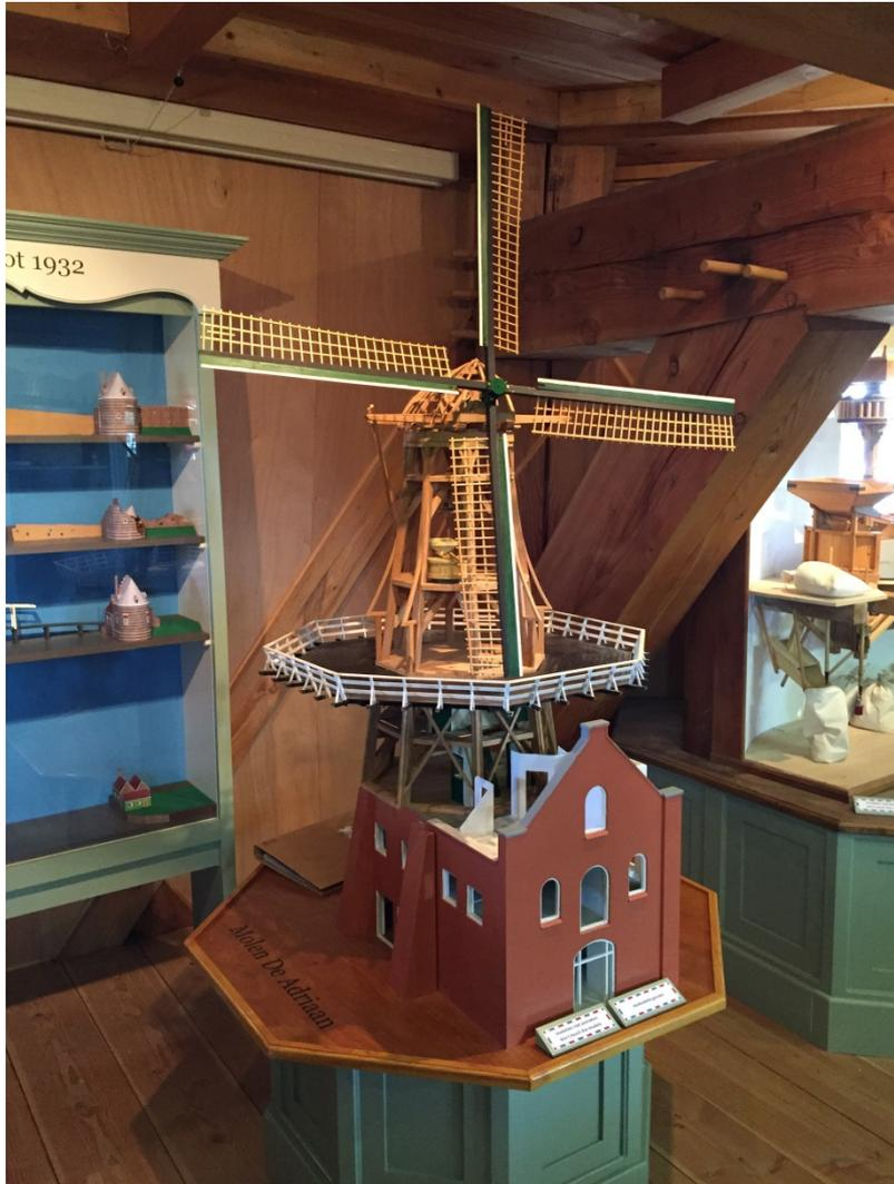
El Adriaan es un molino o molino de bata octogonal con un escenario, construido lo suficientemente alto como para atrapar la mayor cantidad de viento posible. El Adriaan es una bobinadora-superior exterior. Al girar la tapa y aspas, con la rueda de bobinado, las aspas se establecen para hacer frente al viento. La tapa de rueda sobre rodillos, hoy en día en hierro fundido, pero solían ser de madera (recordemos el ejemplo en el piso de abajo)
