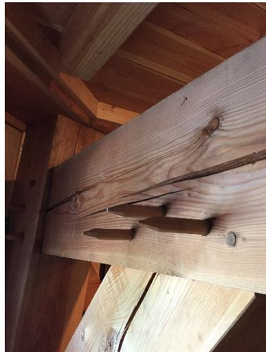
Las vigas de madera del molino están conectados con pasadores de madera, el llamado mortis y espiga conjunta. Esta construcción hizo posible la construcción de partes de la planta en el taller, para desmontar las piezas y reconstruir ellos en el acto. Al mismo tiempo, el molino en su conjunto podría ser desmantelado, vende y reconstruida en otro lugar, lo que ocurrió con frecuencia: una gran cantidad de los molinos de madera se encuentra en un lugar diferente en tiempos pasados.
