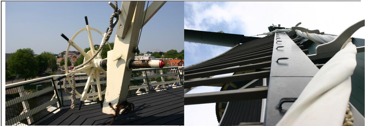
Neben dem Schwanz ist ein dickes Seil, mit dem die Bremse betätigt wird.
