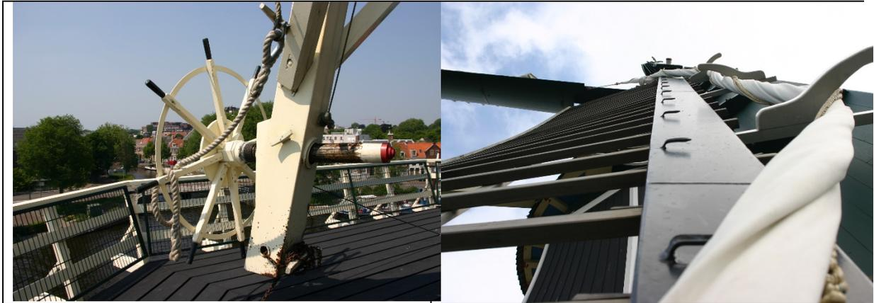
A côté de la queue est une corde d'épaisseur, avec laquelle le frein est actionné.
